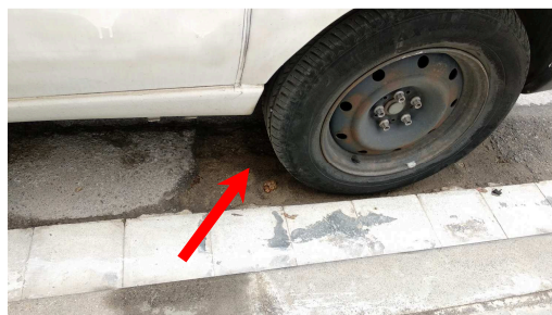
Detall del defecte
