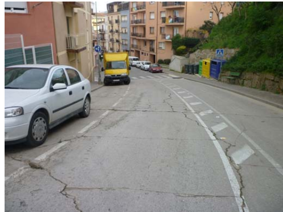
Imatge 92. Exemple aliè al municipi, on s'ha redistribuït i ajustat l'espai de calçada a través d'una mitjana pintada.
