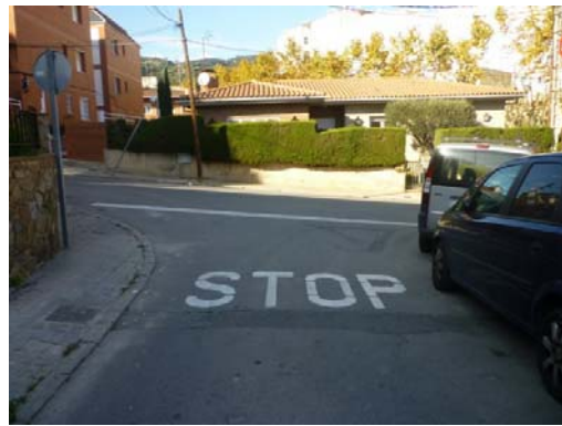
Imatge 62. Manca pas de vianants. Vehicles aparcats on hauria d'haver-hi un pas de vianants.
