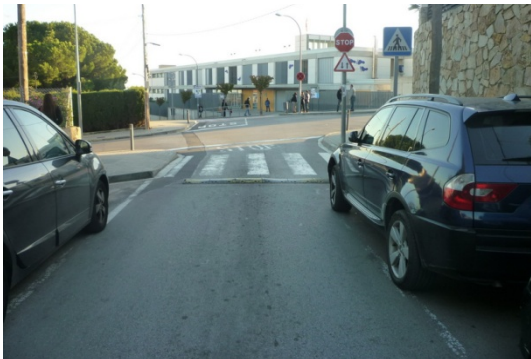
Imatge 97. Pas de vianants. Cal millorar visibilitat.
