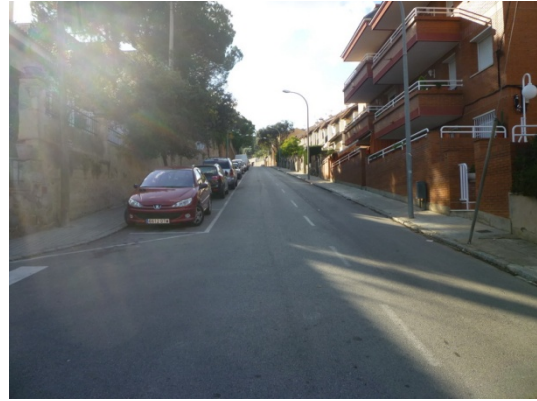
Imatge 4. Mare de Déu de la Cisa. Línia de separació de carrils. Correcte tot i que cal repintar.
