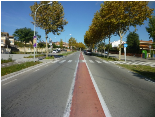
Imatge 91. Exemple d'estrenyiment a la carretera de Premià de Mar pintant una mitjana d'1,0 m.
