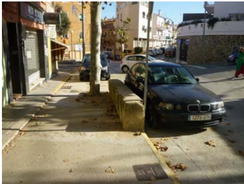
Imatge 57. Cal enderrocar mur per habilitar pas de vianants. Zona pavimentada de la vorera.
