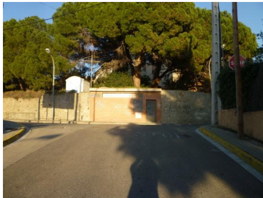
Imatge 5. Aproximació per carrer Bilbao. Estop parcialment tapat.
