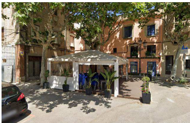
Tarima exterior de la terrassa del bar situat a Plaça de la Vila, 14
